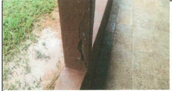
Foto 4: Reparación de columna agrietado en corredor de la escuela.
