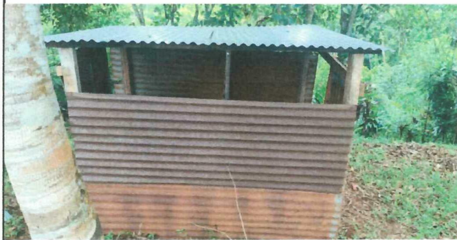
Foto 1: Reparación de servicios sanitarios, debido a que se encuentra en mal estado.
