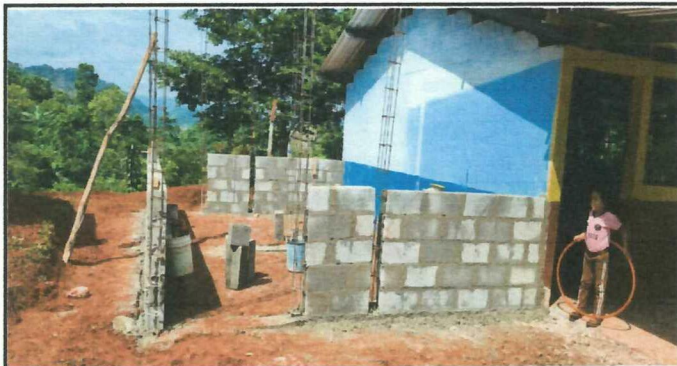
Foto 3: Reparación de muros de mampostería para dirección y bodega.
