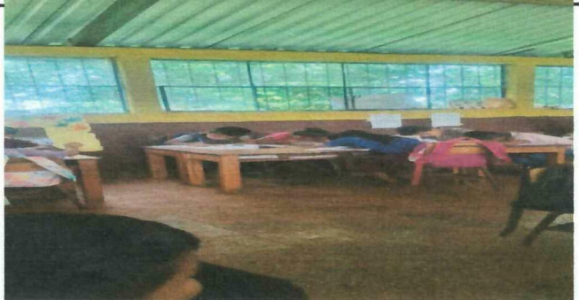
Foto 6: Sustitución de piso rústico por piso cerámico en aulas.
