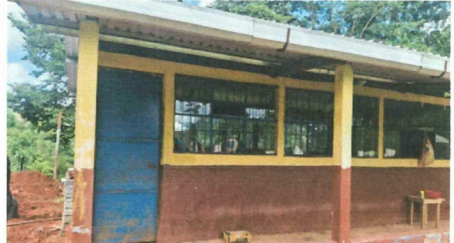
Foto 2: Cambio de abatimiento hacia afuera y pintura acabado de toda la escuela.
